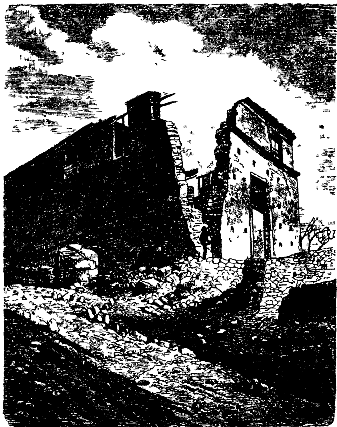
Рис 122 Расщелины большого здания после землетрясения
